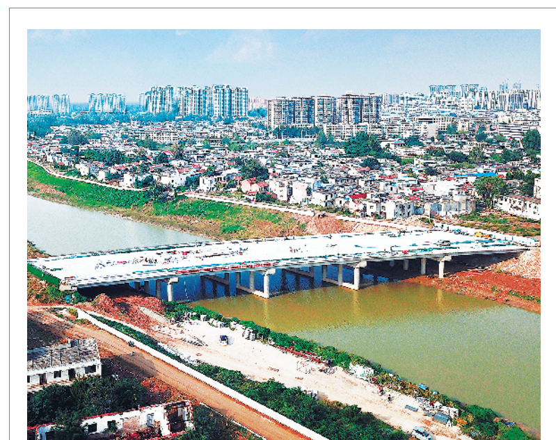
昨日,文昌大道跨贾鲁河大桥施工进展顺利,主体工程已经完成。该桥作为我市重点规划项目,也是文昌大道西延的重要组成部分。记者 沈湛 摄
