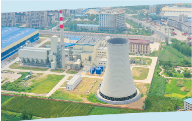
扶沟县先进制造业开发区一角。
