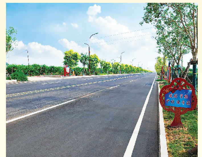
近年来,西华坚持以人民为中心的发展思想,扎实推进“四好农村路”建设,全力把农村公路建成群众家门口的致富路、幸福路,为乡村振兴提供坚实保障。图为西华宽平坦的农村公路。 记者 张猛 孙靖 摄
